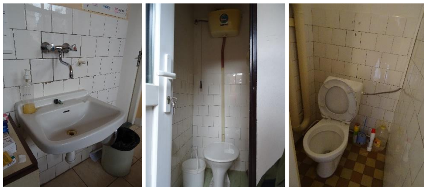
Obr. 18: Zariaďovacie predmety – pôvodná budova
