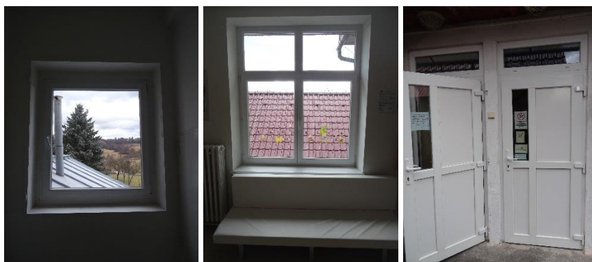
Obr. 12: Vymenené otvorové konštrukcie
